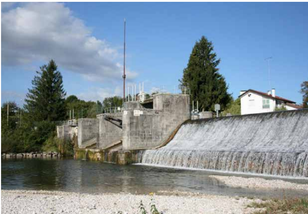
L'opera di presa in sponda destra del T. Torre – IMG_8184
