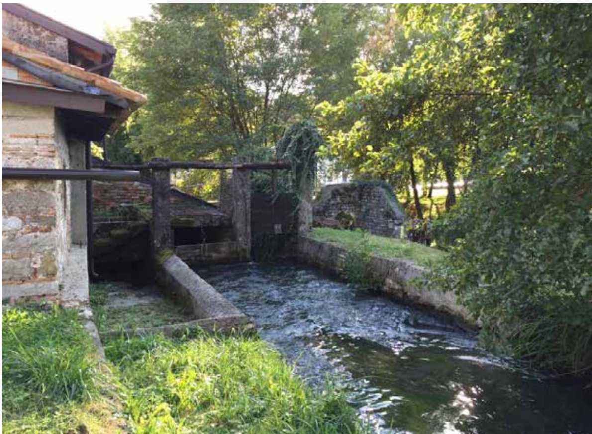
Mulino di Remanzacco, opere di derivazione e sistema di chiuse - IMG_0723
