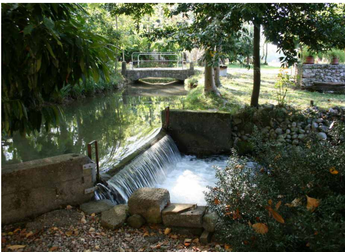
Presso Casali Porpetto la roggia Cividina si divide in due rami: a destra si stacca il ramo originario che si immetterà nel T. Malina, a sinistra prosegue il ramo che con sifone oltrepasserà il torrente – IMG_8410
